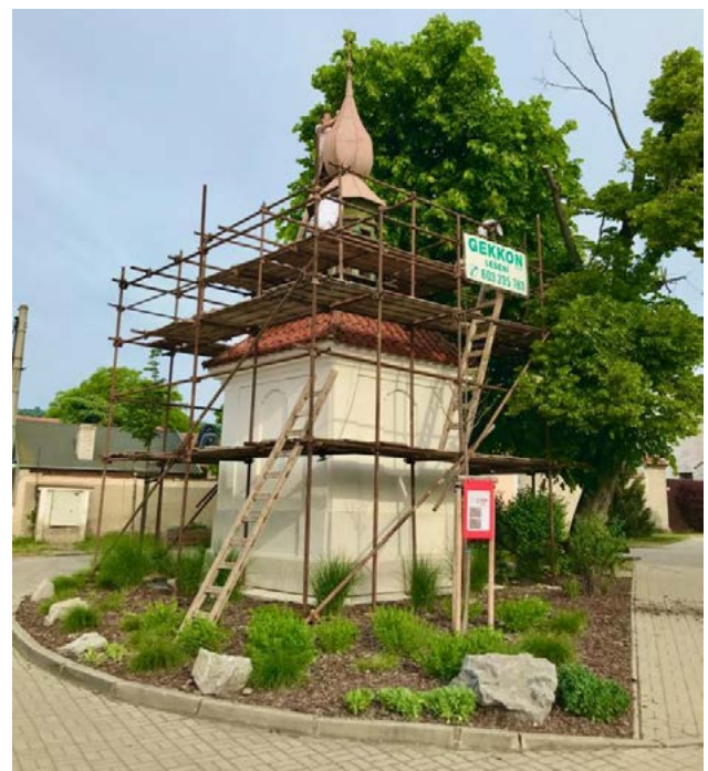
Oprava kapličky – květen 2022
